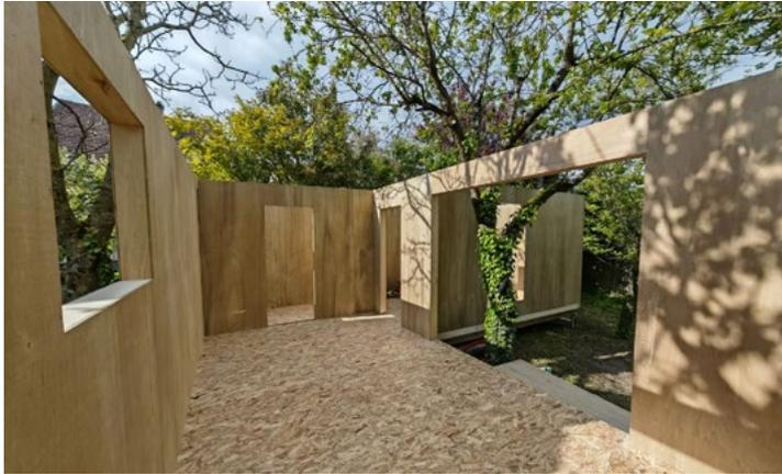
Les studios EdenCube sont conçus à partir de panneaux sandwichs EdenBLOC qui viennent s'imbriquer les uns dans les autres et qui sont par la suite verrouillés par des clés d'assemblage.
