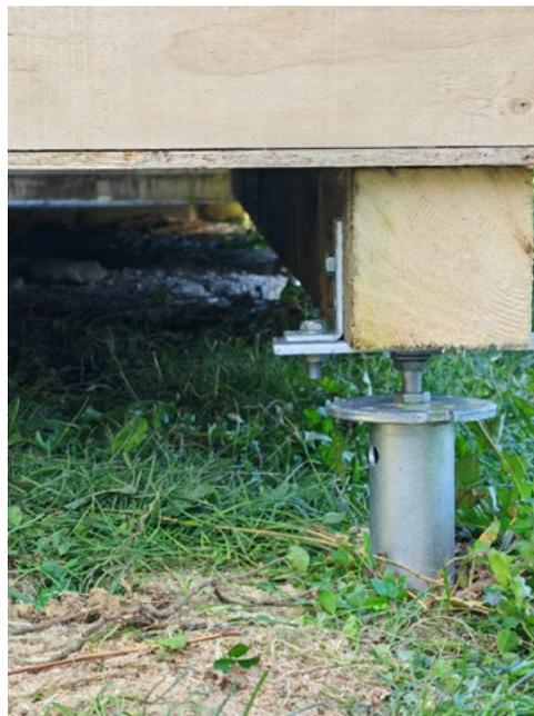
Contrairement aux fondations traditionnelles en béton les vis de fondation Weasyfix sont conçues pour préserver la perméabilité naturelle du sol.
