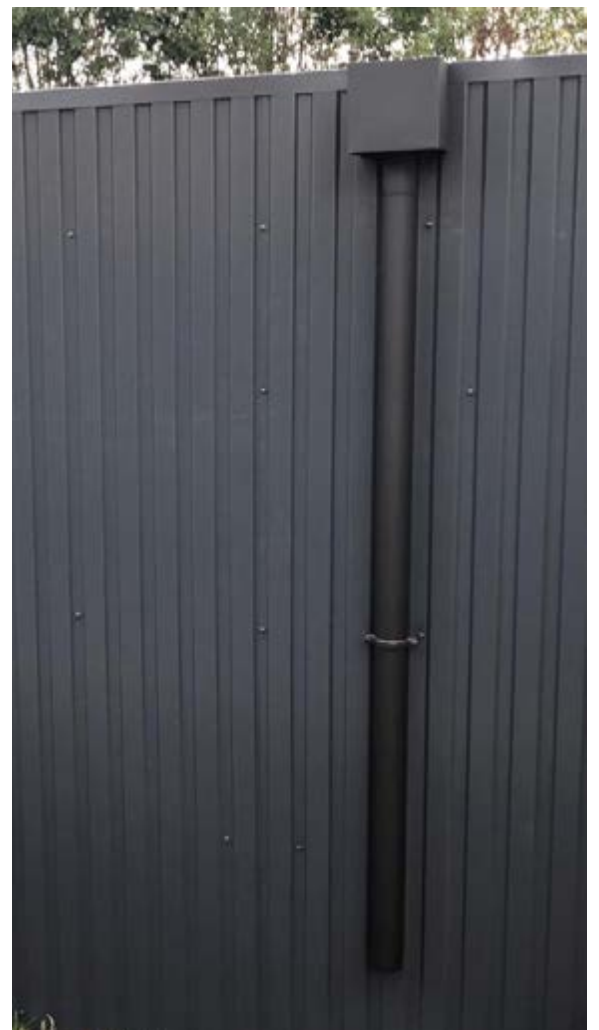
Boîte à eau et descente d'eau pluviale horizontale
